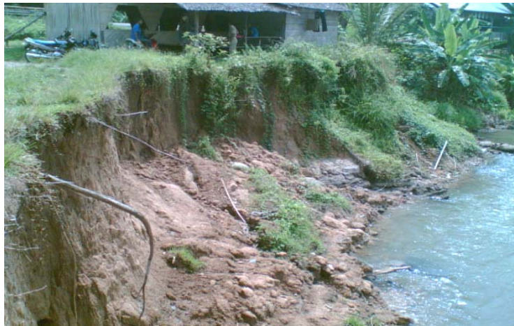
Gambar 3.15. Longsoran dinding Sungai Enim
